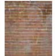
l) brick structure
